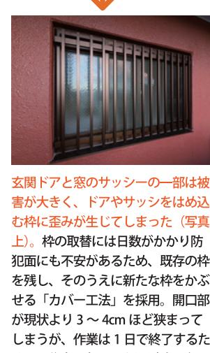
玄関ドアと窓のサッシの一部は被害が大きく、ドアやサッシをはめ込む枠に歪みが生じてしまった（写真上）。枠の取替には日数がかかり防犯面にも不安があるため、既存の枠を残し、そのうえに新たな枠をかぶせる「カバー工法」を採用。開口部が現状より3～4cmほど狭まってしまうが、作業は1日で終了するため、居住者は部屋から退避する必要がなかった。
